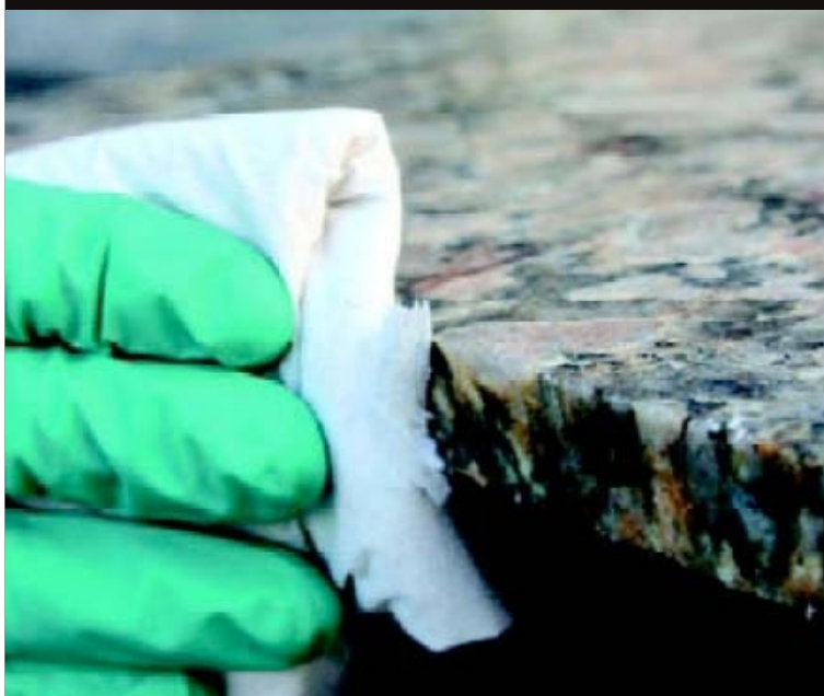
VORBEREITUNG DER KANTEN
